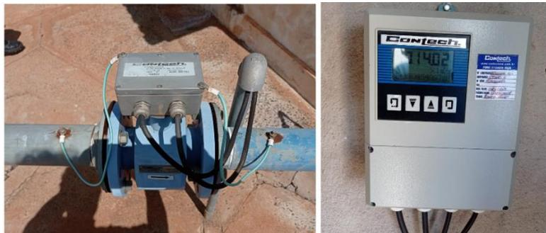
Ressalta-se que, esses medidores são interligados ao sistema de automação industrial e monitorados pelo Centro de Controle Operacional. Dessa forma, torna-se possível saber em tempo real a vazão de produção do poço de água remotamente através do computador. Na Figura 2, mostra-se uma tela do sistema supervisório de exemplo, na qual é possível ler a vazão do poço.
