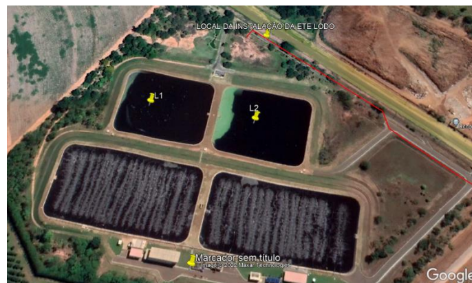
Figura 1: Local das lagoas de tratamento de esgoto ETE Catanduva.
