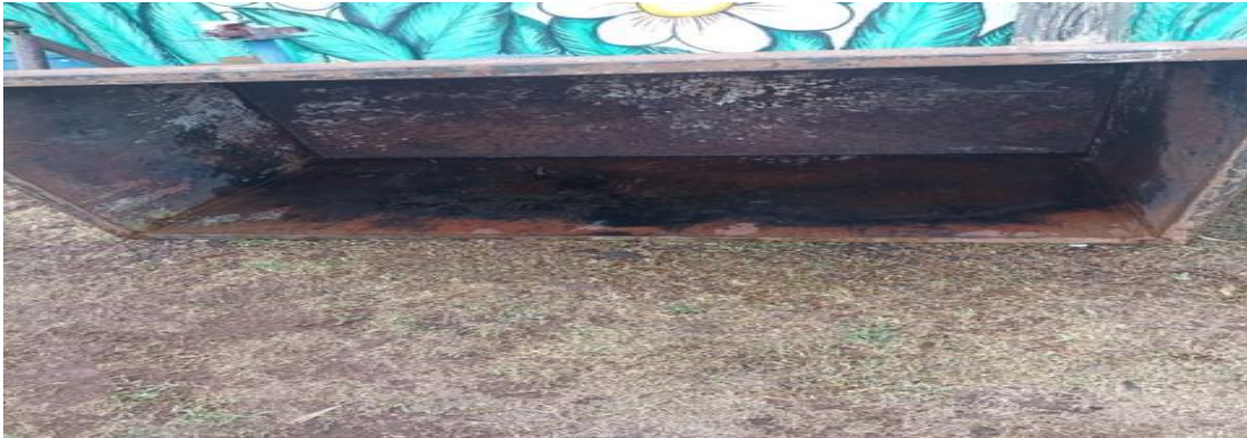
Figura 3: Contentor em processo de reforma, aplicado fundo antiferrugem.
