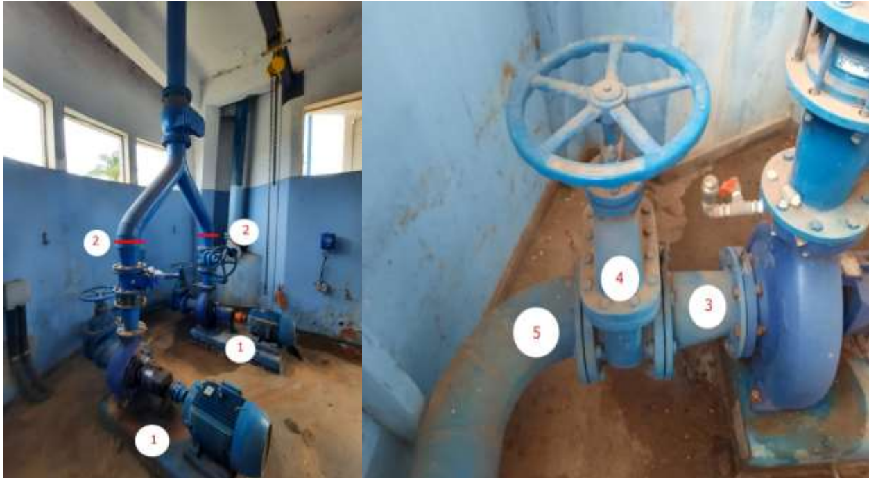
Figura 2 - imagem do local a de instalação das bases
