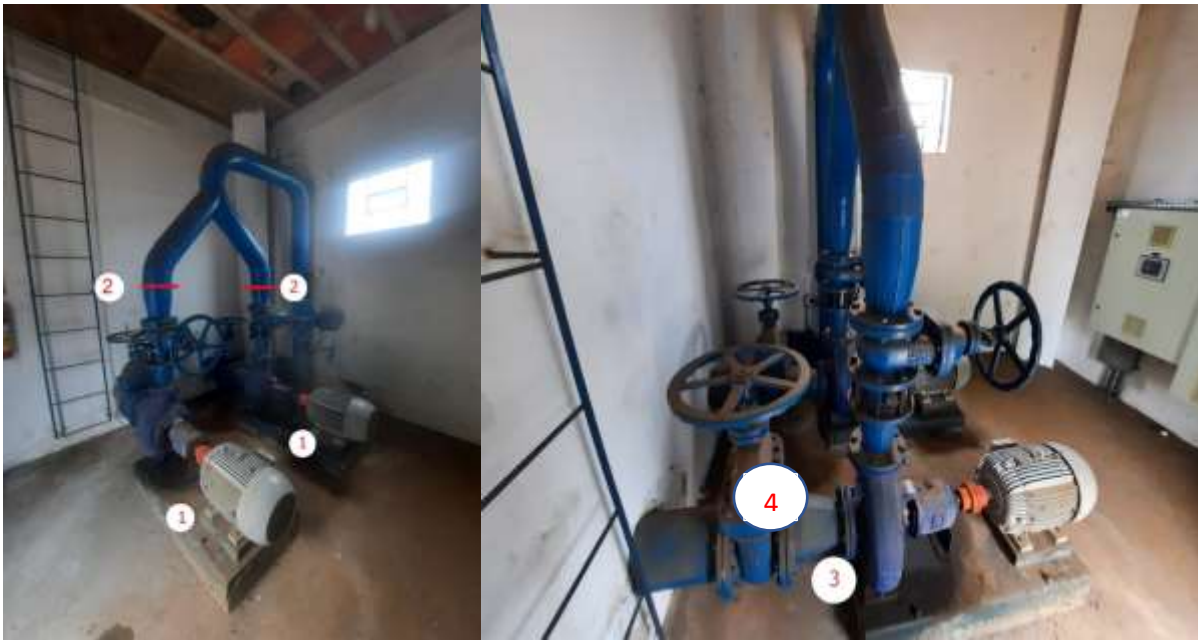
Figura 1 – imagem do local a de instalação das bases
