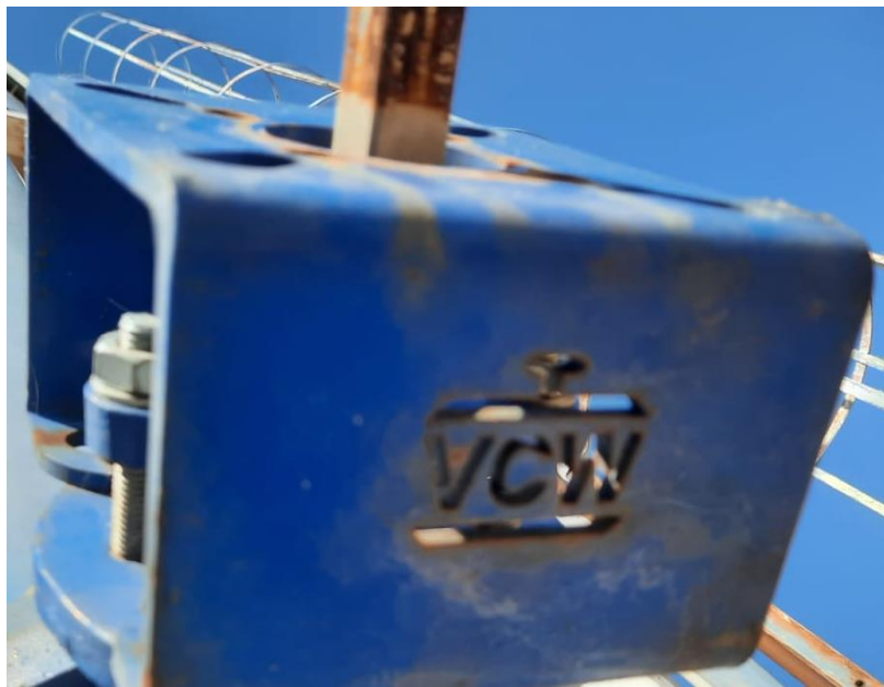
Figura 4 Suporte para fixação do atuador elétrico
