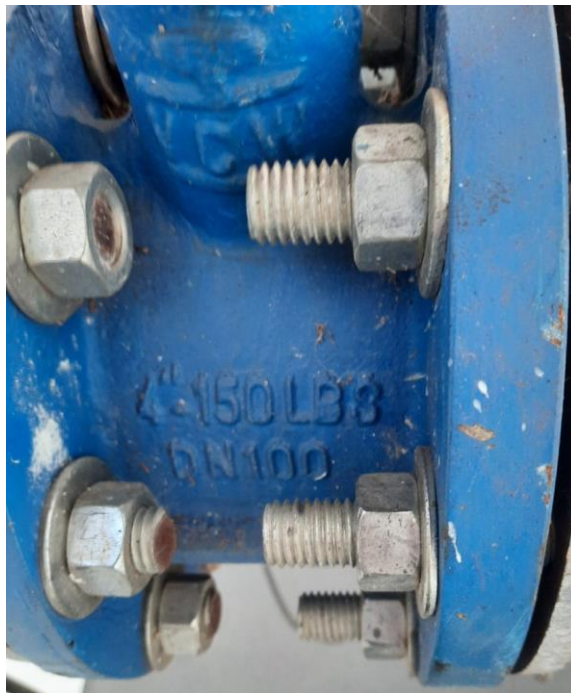
Figura 1 Válvula tipo borboleta 4" VCW
